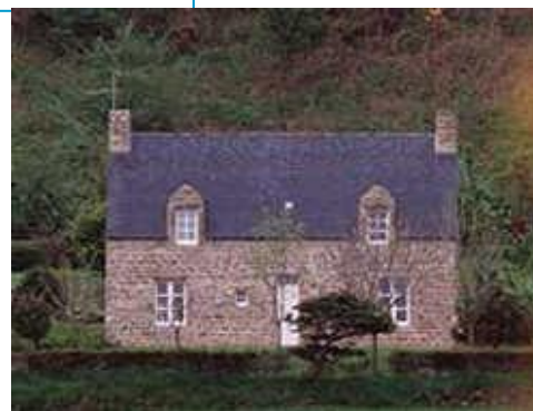
Maison en granite dans la Manche
